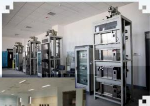
智能电梯安装调试 维护训练场所
